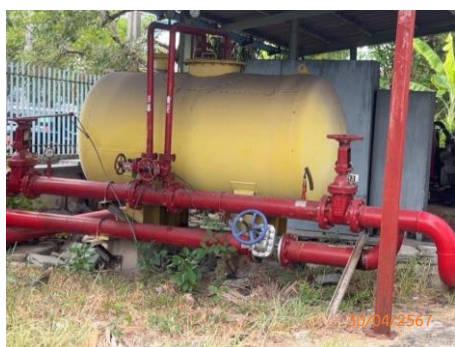
ภาพที่ 2.2-39 แนวท่อน้ำดับเพลิง และแนวท่อโฟมดับเพลิง
