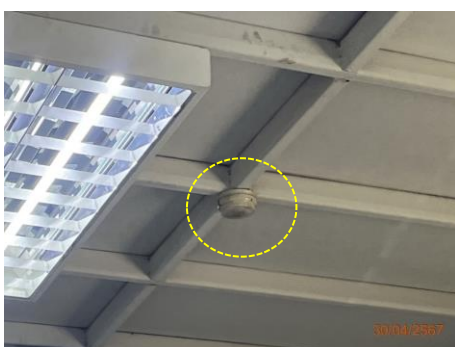
ภาพที่ 2.2-37 ระบบตรวจจับความร้อน (Heat Detector) บริเวณพื้นที่ Store
