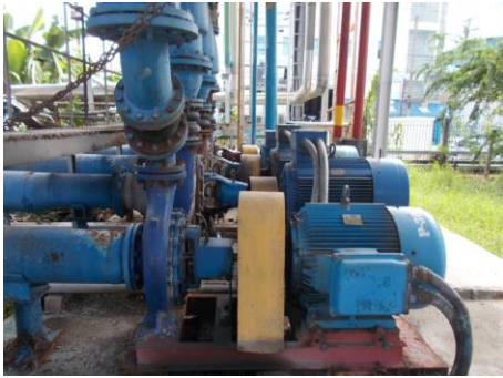
ภาพที่ 2.2-27 อุปกรณ์ครอบเครื่องจักร ที่มีการหมุน
