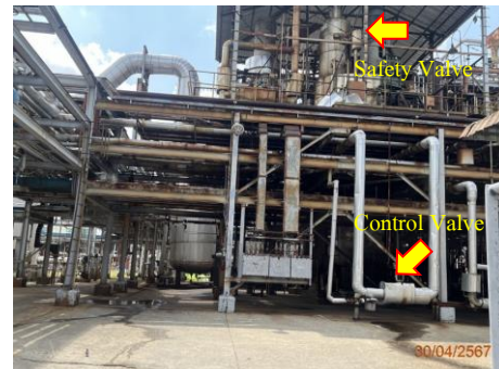
ภาพที่ 2.2-30 Safety Equipment และ Control Equipment
